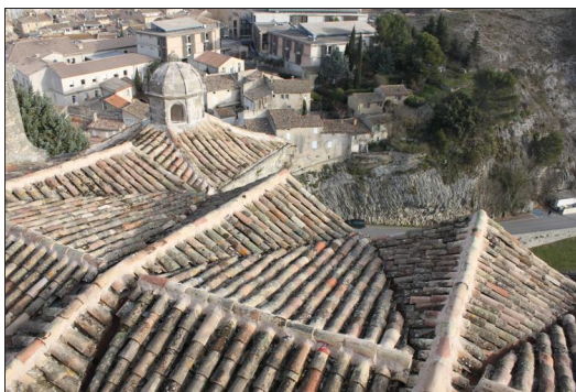
Les différents toits de la cathédrale de la cité médiévale vont être rénovés sur quatre tranches. La première tranche va commencer et devrait se terminer en septembre 2019. Photo Le Dauphiné RCD
